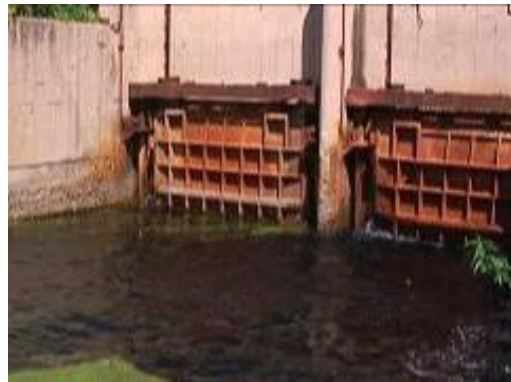
串湖污水处理厂排放口
