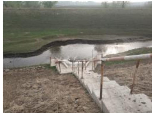
兰家污水处理厂排放口
